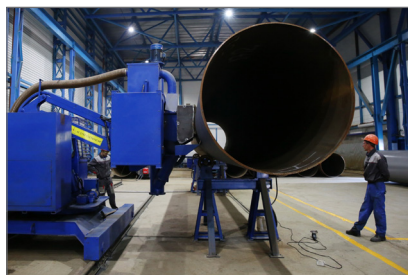
Идет очистка поверхности трубы
