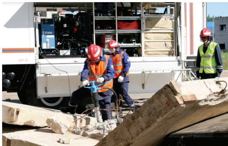
Для того, чтобы добраться до пострадавшего, сломали плиту перекрытия
