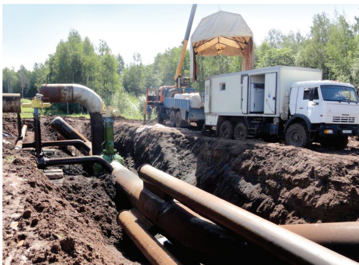
Работы на узле подключения № 1 МГ «Нижняя Тура – Пермь 2» в зоне ответственности Пермского ЛПУМГ
