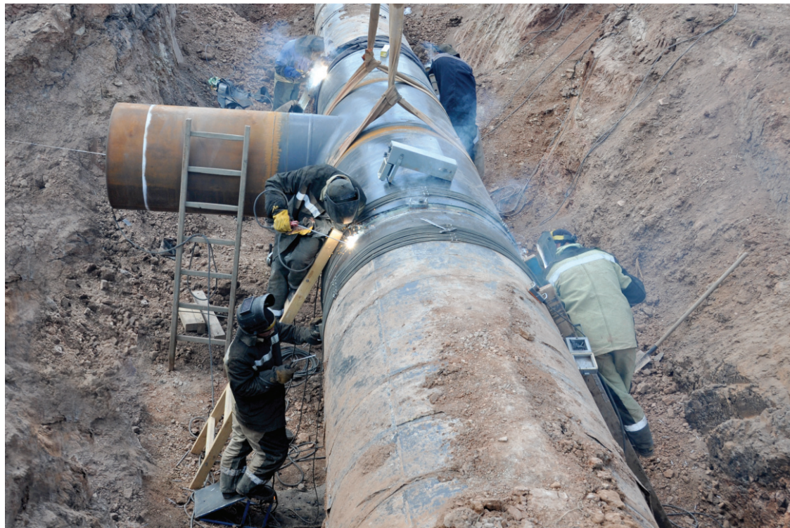
Ремонт участка МГ «Ямбург – Елец 2» в зоне ответственности Можгинского ЛПУ/МГ
