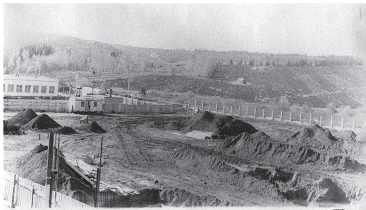
Строительство КС «Оханская» Ижевского ЛПУМГ ПО «Горькийтрансгаз», 1974 г.
