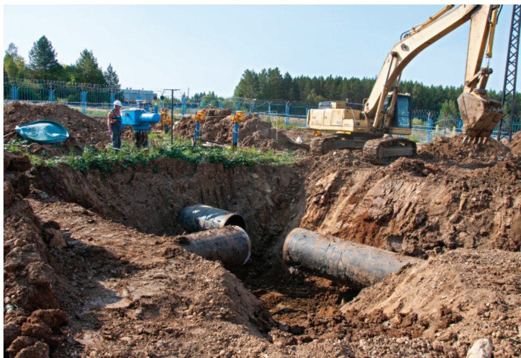
Работы на узле подключения КЦ № 1 (МГ Уренгой – Петровск) Алмазного ЛПУМГ
