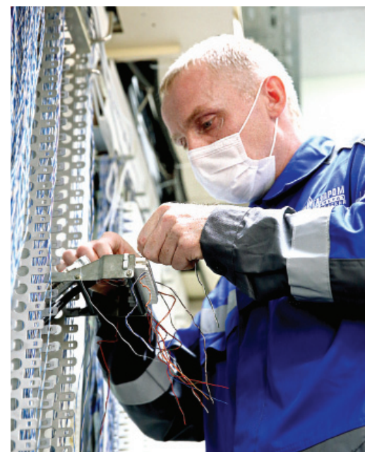
Конкурс электромонтёров линейных сооружений телефонной связи и радиофикации. На фото слева – проведение измерения на волоконно-оптическом кабеле, в центре – сварка оптического волокна, справа – монтаж медного кабеля на плиту типа «KRONE»
