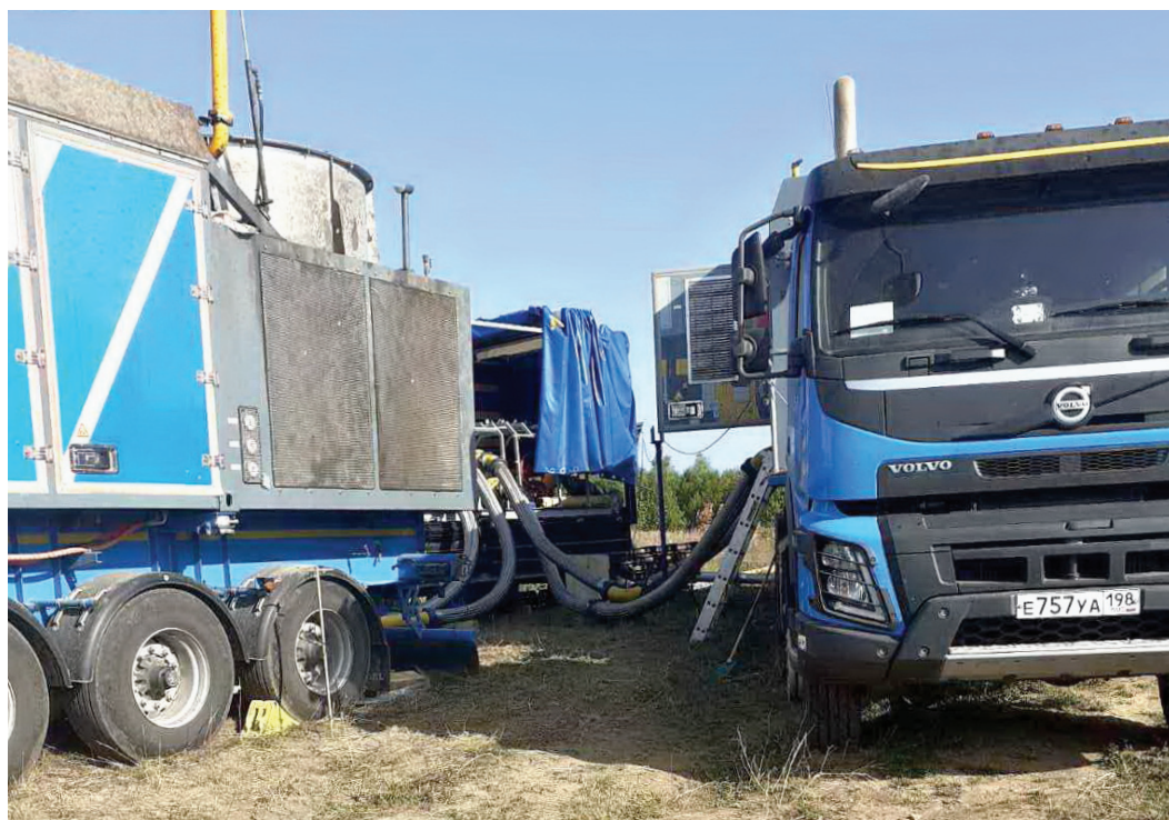
Процесс перекачки газа из выводимого в ремонт участка МГ «Ямбург – Елец II» с помощью мобильной компрессорной станции. Перед началом перекачки, которую выполняет подрядная организация, специалисты Чусовской ЛЭС Горнозаводского ЛПУМГ провели работы по подключению входных и выходных шлейфов МКС к крановым узлам магистральных газопроводов – из которого и в который перекачивают газ
