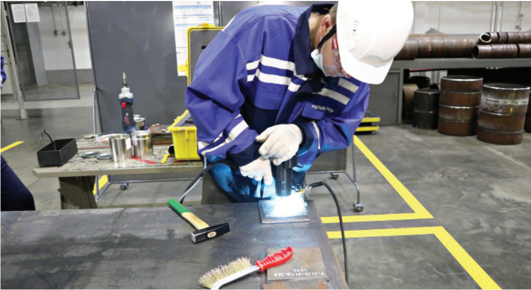
Процесс аттестации технологии пайки выводов ЭХЗ проводит электромонтёр воздушных линий электропередач Чайковского ЛПУМГ, специалист сварочного производства 1 уровня Сергей Беляев
