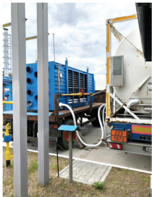
Последние три года при проведении капитального ремонта участков газопроводов, где невозможно провести отключение потребителей, в Обществе успешно применяется технология с использованием сжиженного природного газа
