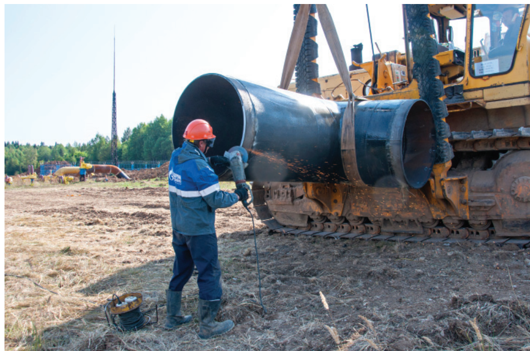
Подготовка к монтажу тройникового узла Ду 1000х1000 мм
