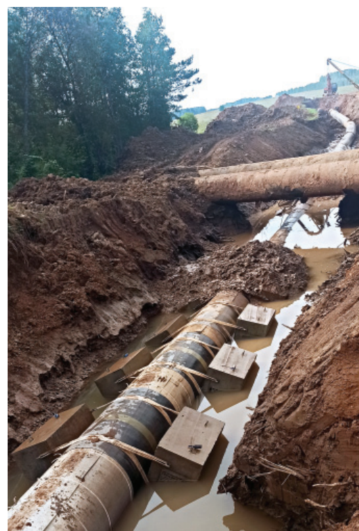
Бетонные балластирующие устройства удерживают трубу в земле от всплытия
