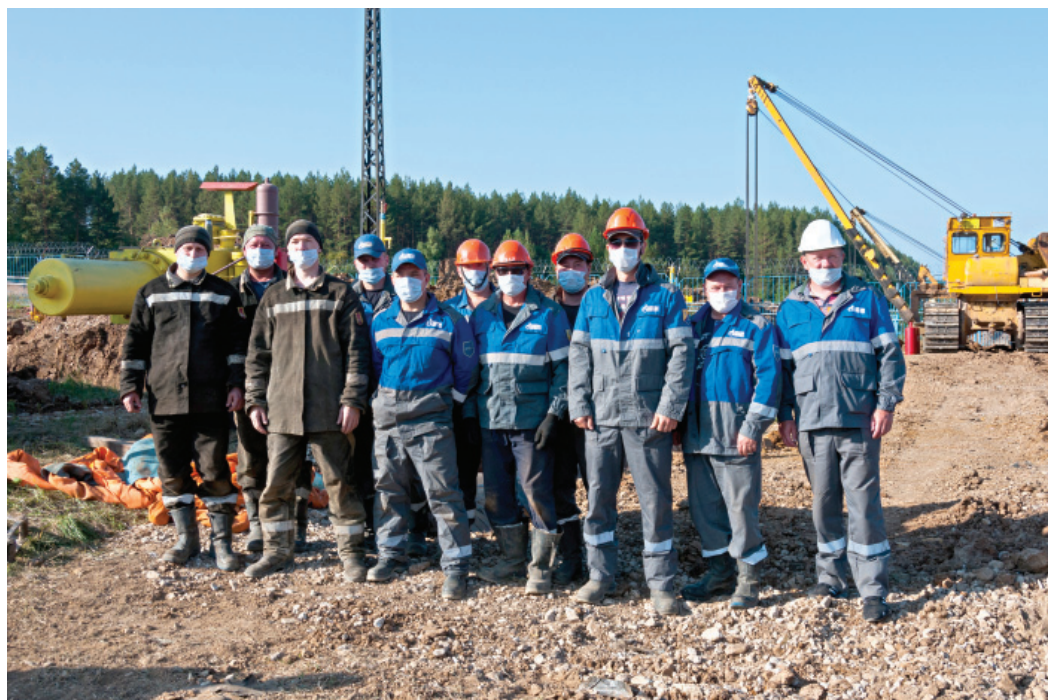
Бригада УАВР № 1 под руководством мастера Игоря Шаршавина, выполняющая работы на узле подключения КЦ № 1 Алмазного ЛПУМГ
