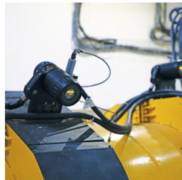
Ультразвуковые преобразователи расхода газа передают данные не только о расходе газа, но и о его качественных показателях
