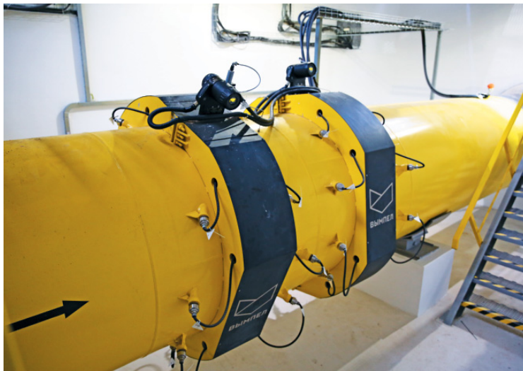
Ультразвуковой измерительный комплекс новой ГИС смонтирован в действующий МГ «Ямбург – Тула I»
