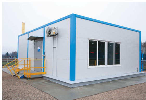
Модульное здание, защищающее современную ГИС от внешнего воздействия
