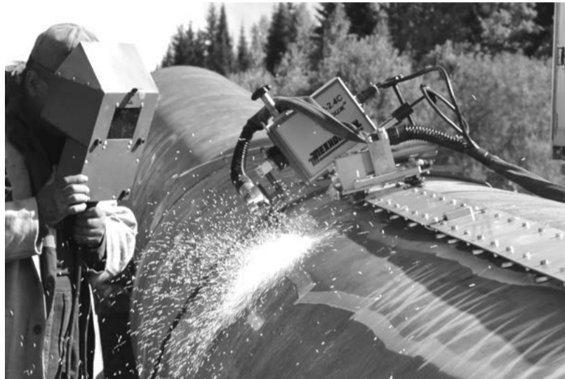
Плазменная строжка (выборка) стресс-коррозионных трещин с поверхности трубы диаметром 1420 мм.
