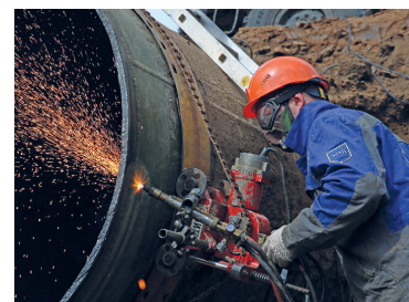
Газорезчик выполняет «чистовой рез» конца трубы машинной орбитальной газокислородной резки «Орбита БМ»
