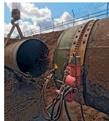
Подготовка соединяемых кромок труб к монтажу «захлёста»
