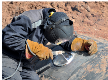
Электрогазосварщик выполняет сварку заполняющих швов шва сварки технологического отверстия
