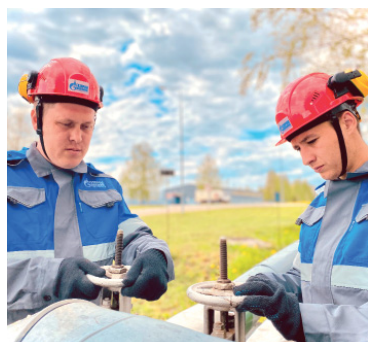
Обслуживание запорной арматуры тепловой сети
