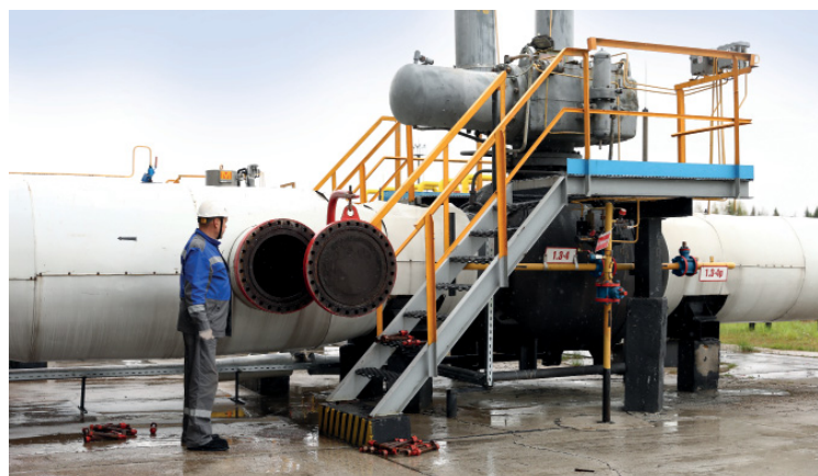
Начальник ГКС № 2 Виктор Хлызов у открытого люк-лаза – места загрузки робота-дефектоскопа
