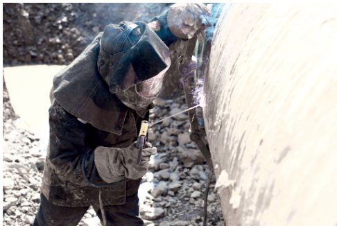
Работы по монтажу противоподавковых и силовых заглушек
