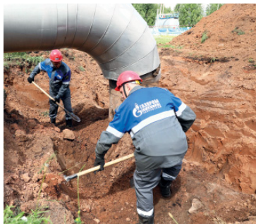
Шурфовка дефектного участка по результатам ВТД
