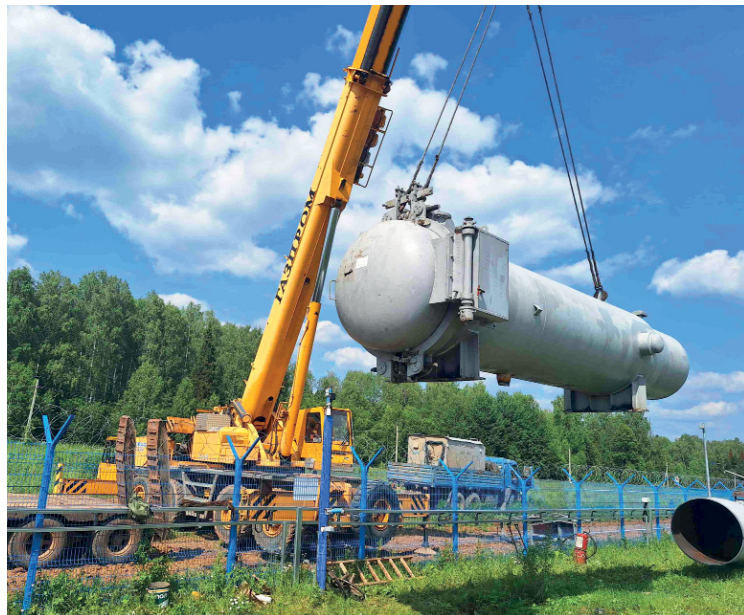
Демонтаж камеры приёма-запуска внутритрубных устройств
