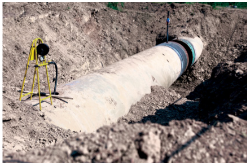
Контроль давления во временном герметизирующем устройстве с помощью манометрической стойки
