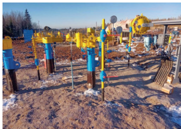
КРТТ на узле подключения КЦ № 6 в Гремячинском ЛПУМГ
