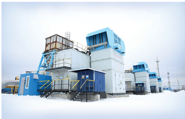
ГПА-Ц-16 ПМ с двигателем ПС-90ГТ-2М, оснащённый малоэмиссионной камерой сгорания на КС «Чайковская»
