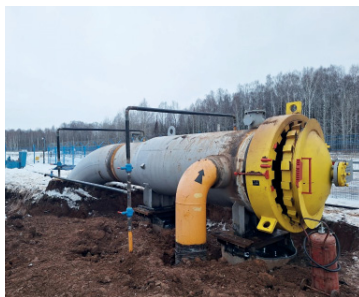
Процесс монтажа камер приёма и запуска внутритрубного устройства
