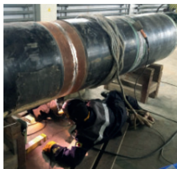
Испытания источников ДС 315.33М и УРАЛ-Мастер-300 (07) на базе УАВР № 3 Общества «Газпром трансгаз Екатеринбург»
