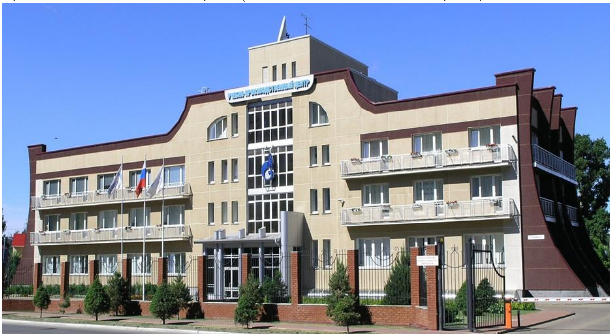
Рисунок 7 – Учебно-производственный центр ООО «Газпром трансгаз Чайковский»
