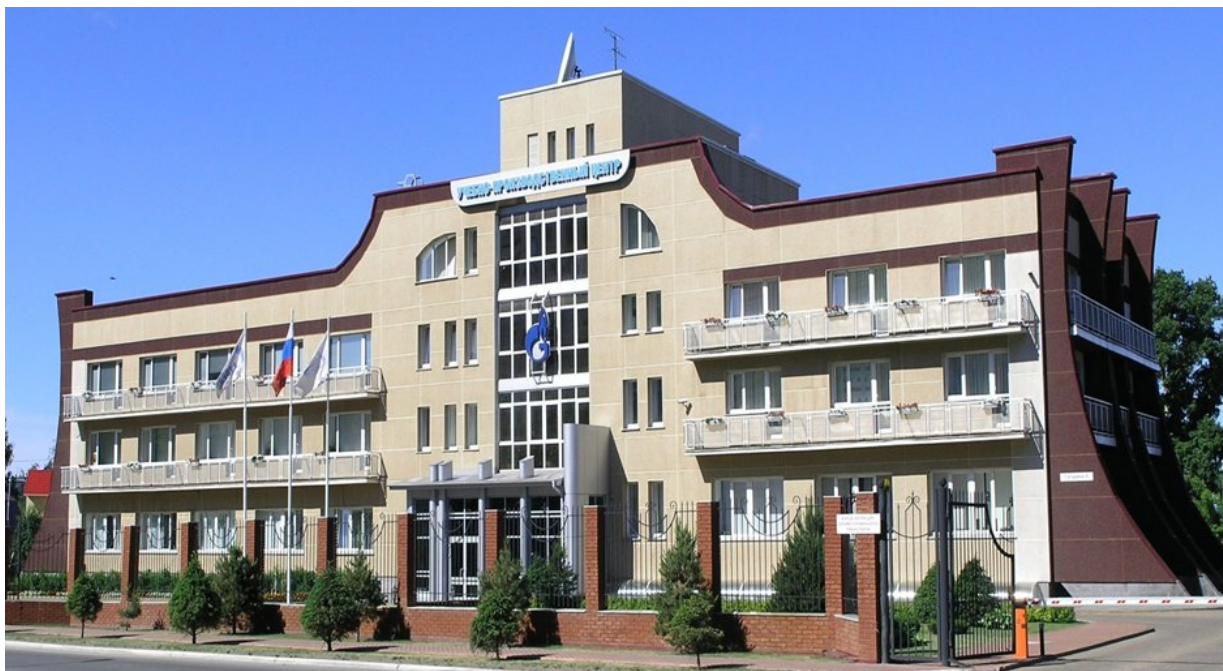
Рисунок 8 – Учебно-производственный центр ООО «Газпром трансгаз Чайковский»
